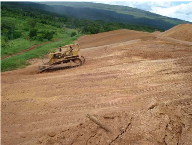
Perfilado de taludes parte del proceso de rehabilitación progresiva de las escombreras y de cierre progresivo
